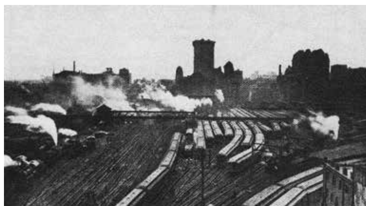
Hauptbahnhof der New York Central and Hudson River-Bahn. Vor der Einführung des elektrischen Betriebes.
