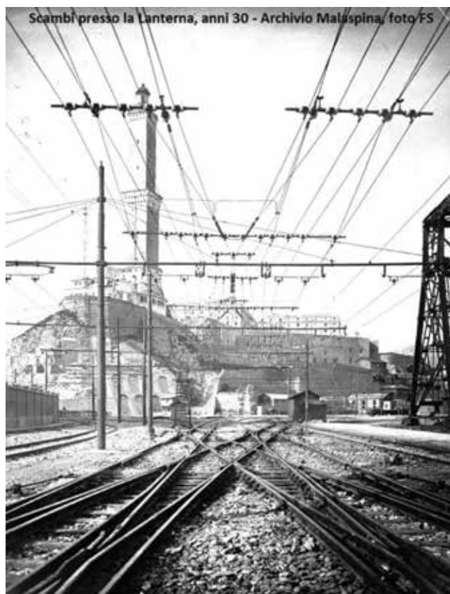
12. ábra. Háromfázisú vezeték a váltóközvet felett.
